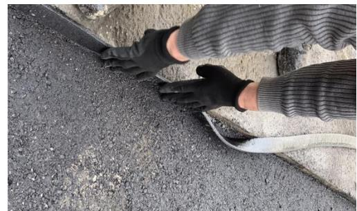
Das **Corabit KK Fugenband** ist ein für den Straßenbau entwickeltes kaltklebendes, co-extrudiertes Fugenband auf Bitumenbasis mit einer synthetischen Klebeschicht.
